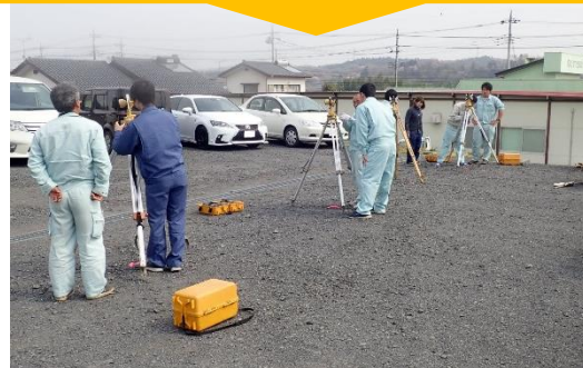
早速ミラーの据付実技指導
